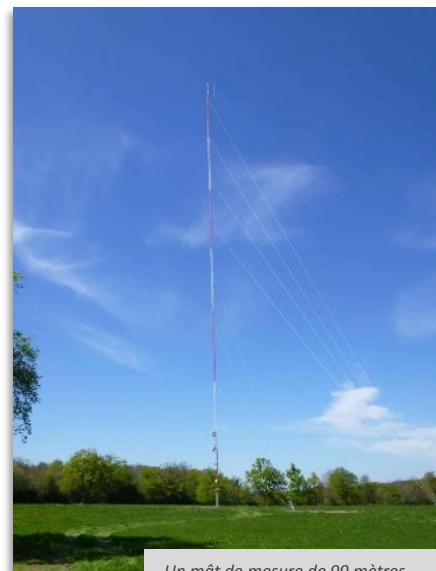
Un mât de mesure de 99 mètres.
